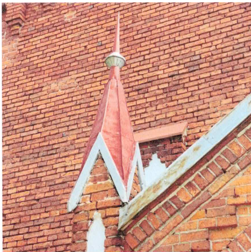
Fot. 31 Szczegół przedstawiający istniejący stan obróbek blacharskich sterczyn
