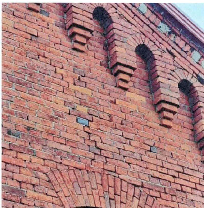
Fot. 18 Szczegół przedstawiający stan pęknięcia, zarysowania muru na elewacji wschodniej budynku kościoła.
