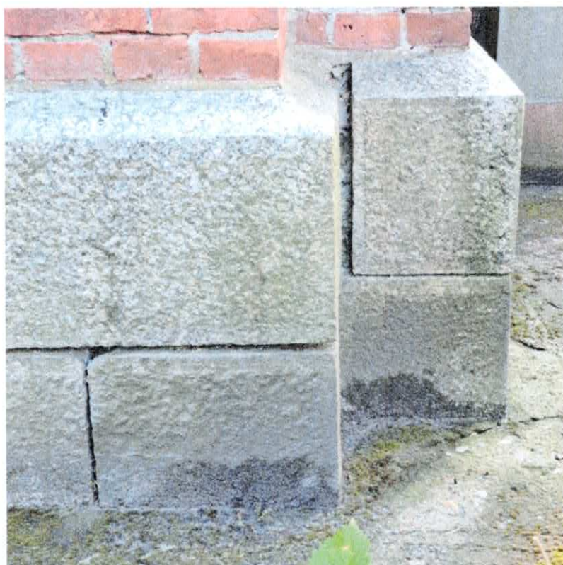
Fot. 27 Szczegół przedstawiający brak spoinowania ciosów kamiennych cokołu elewacji kościoła
