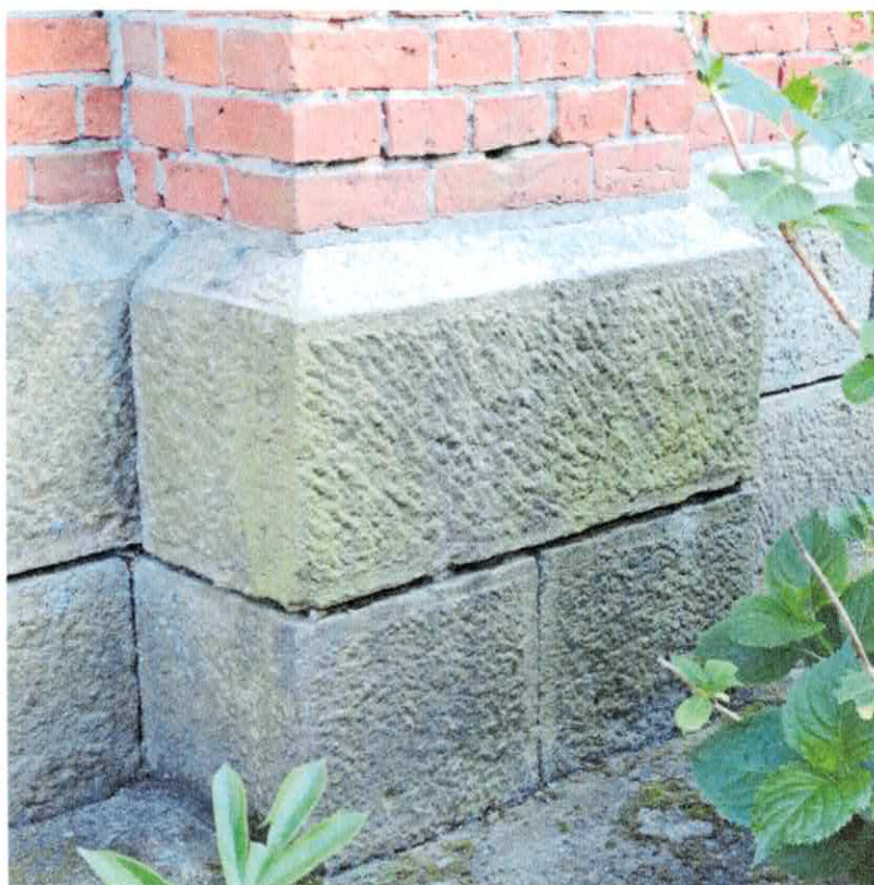
Fot. 26 Widok przedstawiający ogólny stan porażenia przez mikroby murów oraz cokołu kościoła. Skutek zawilgocenia ścian.
