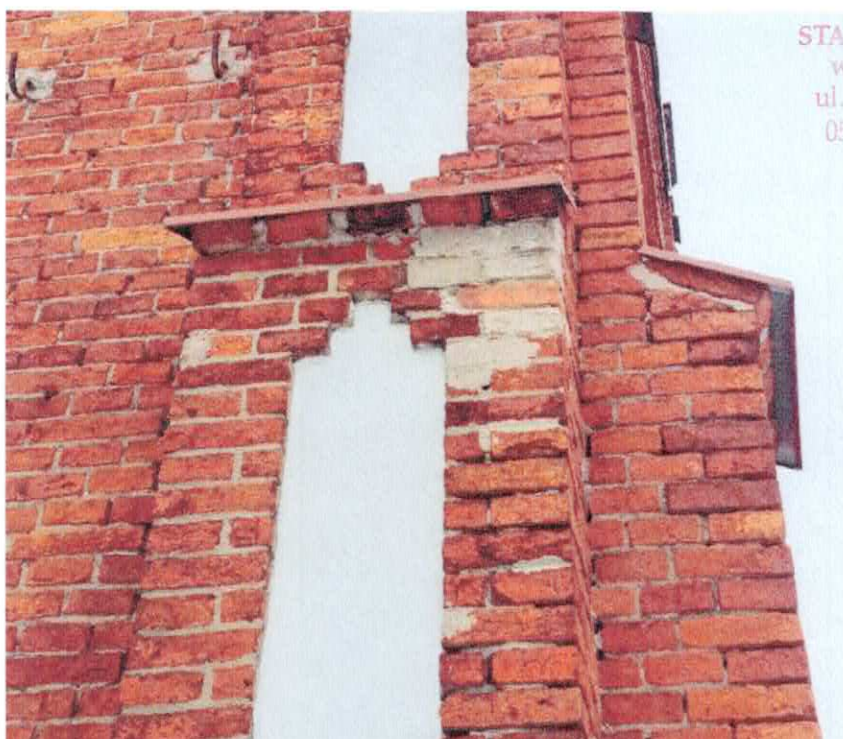
Fot. 14 Szczegół przedstawiający stan naprawy ubytków muru poprzez „flekowanie” zaprawą cementową.
