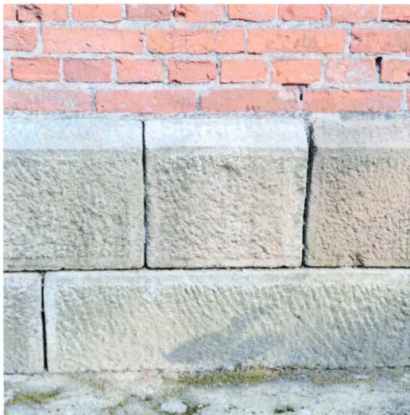
Fot. 30 Przykład braku spoinowania cokołu kamiennego ścian kościoła
