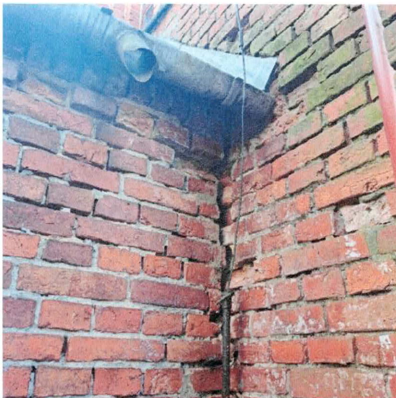
Fot. 25 Widok przedstawiający ogólny stan porażenia przez mikroby murów oraz cokołu kościoła. Skutek zawilgocenia ścian.
