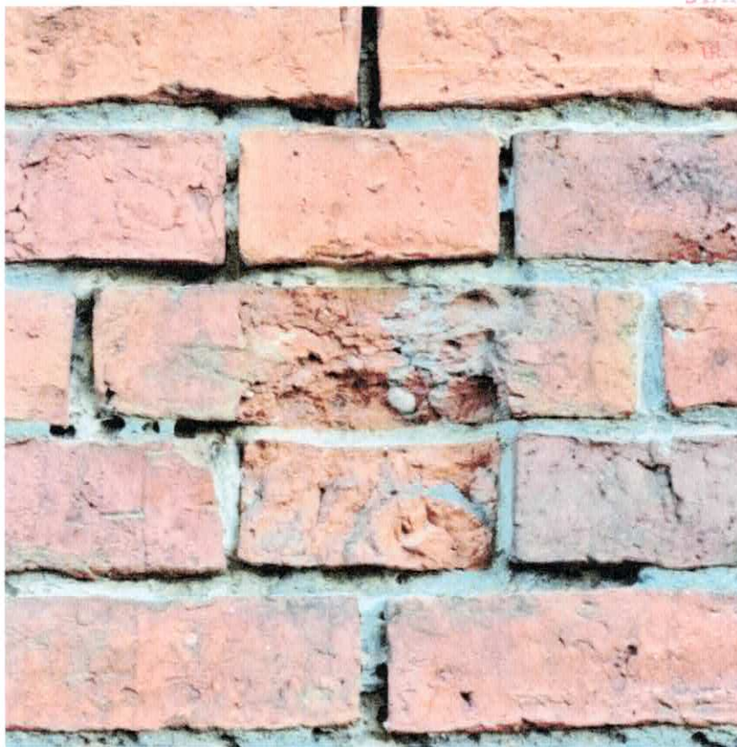
Fot. 12 Widok uszkodzeń muru i stanu spoinowania elewacji ścian kościoła.
