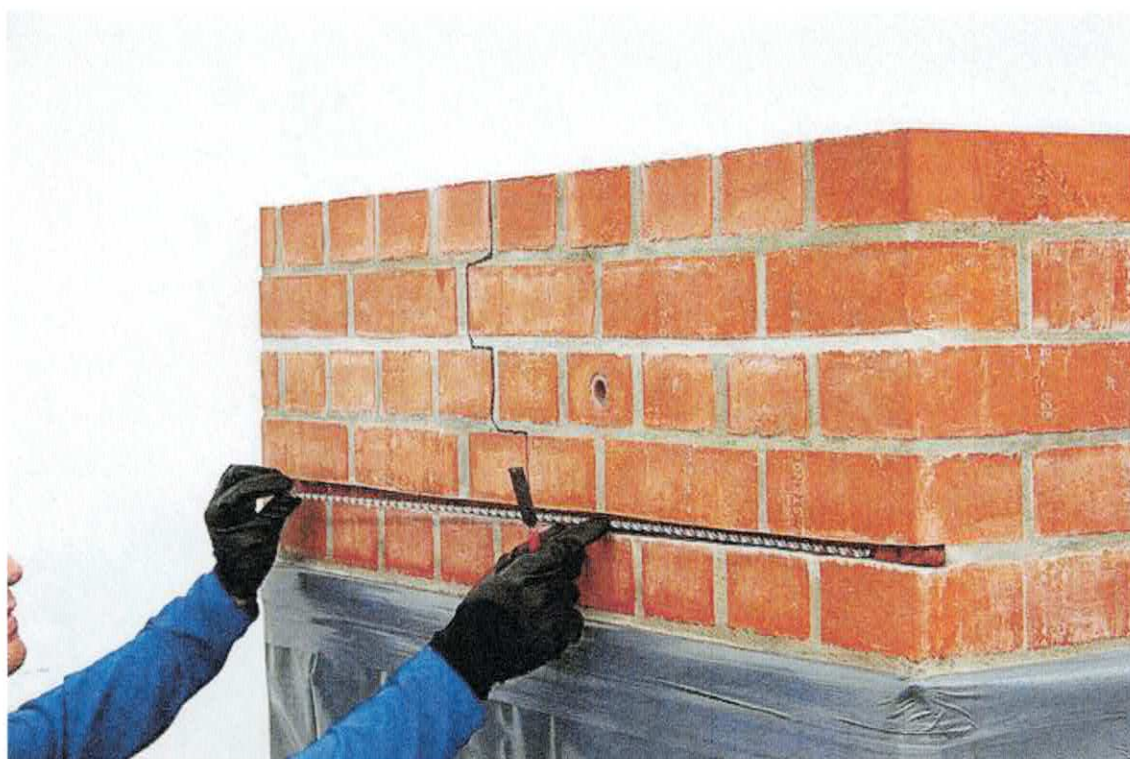
Fot. 1 Fotografia poglądowa dotycząca wykonania wzmocnienia rys, pęknięć w murze.
