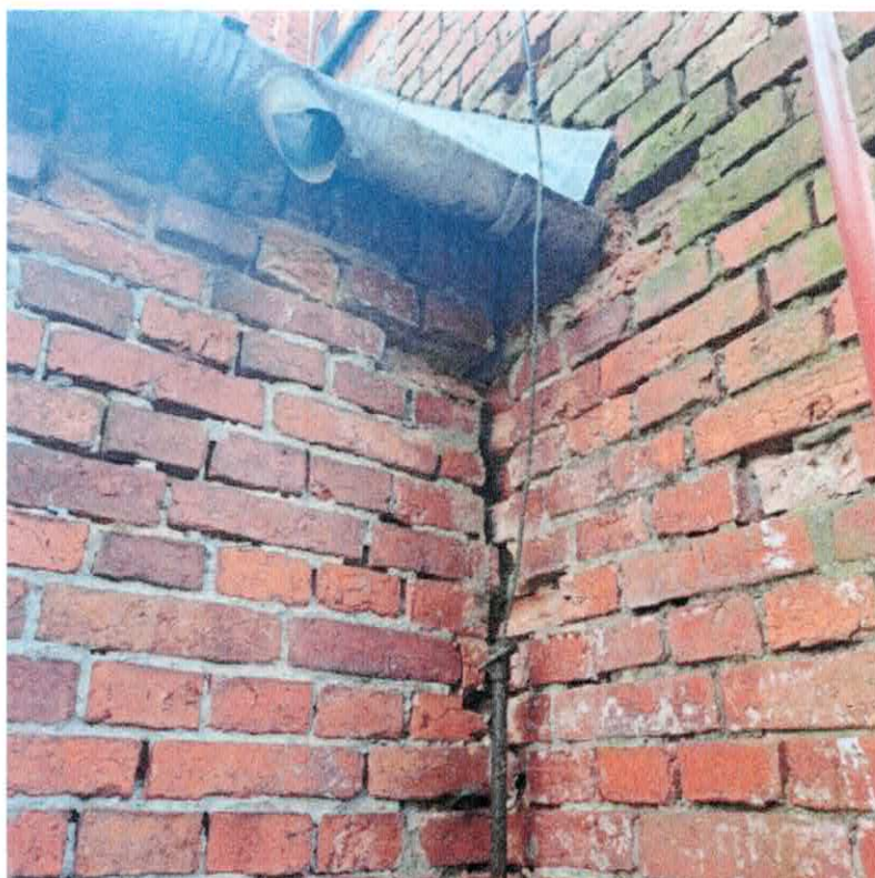
Fot. 19 Szczegół przedstawiający stan porażenia murów elewacji kościoła przez mikroorganizmy
