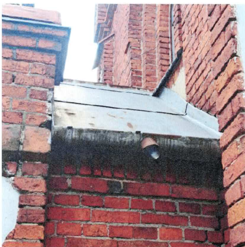
Fot. 22, 23 Widok przedstawiający ogólny stan zniszczenia pokrycia dachów krucht na obiekcie kościoła.
