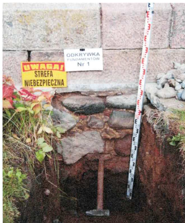
Fot. 7,8 Odkrywki kontrolne nr 1 i 2 fundamentów kościoła (2009 r.)
