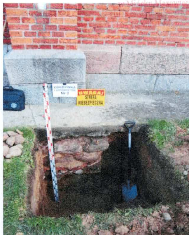
Fot. 7,8 Odkrywki kontrolne nr 1 i 2 fundamentów kościoła (2009 r.)
