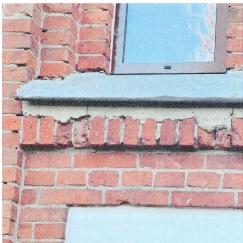
Fot. 15 Szczegół przedstawiający stan naprawy ubytków muru poprzez uzupełnianie ubytków muru zaprawą cementową.
