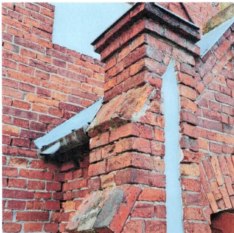
Fot. 17 Widok przedstawiający ogólny stan zniszczenia szkarpy przypory muru na kruchcie południowo-wschodniej, widoczny ubytek cegieł szkarpy muru oraz brak spoinowania.
